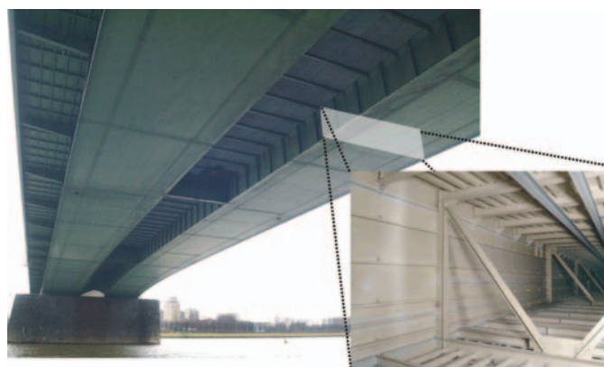
Bild 2. Sanierung des inneren Hohlraumes der Südbrücke Düsseldorf
