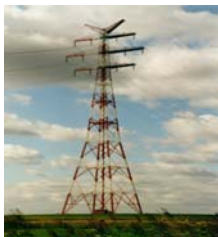
Hochspannungsmast „Elbekreuzung“ mit Warnanstrich, 228 m hoch
